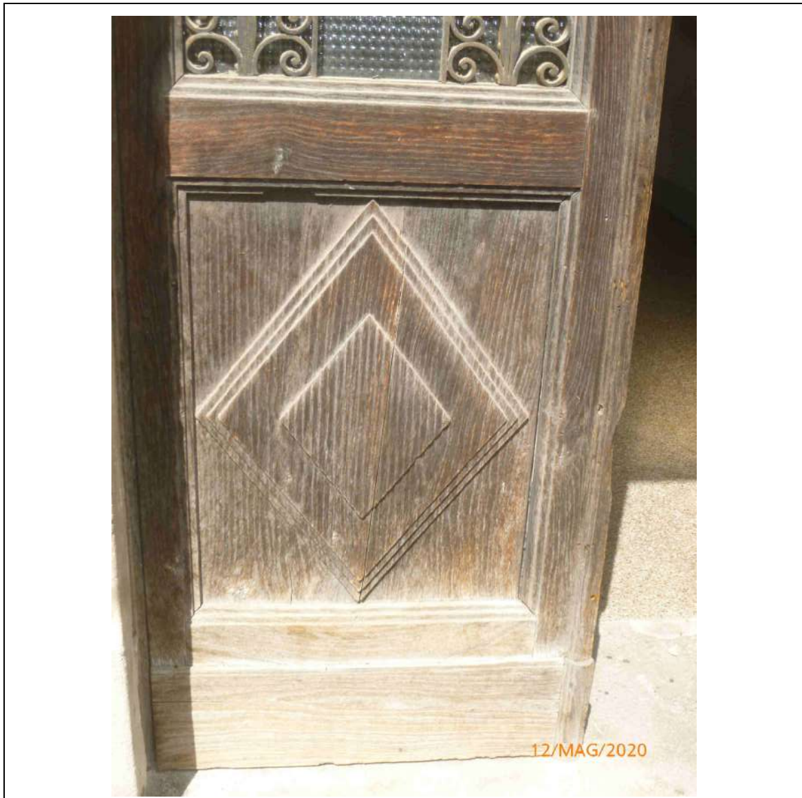
Foto 19 – Stato di fatto – Dettaglio pannellatura porta ingresso
