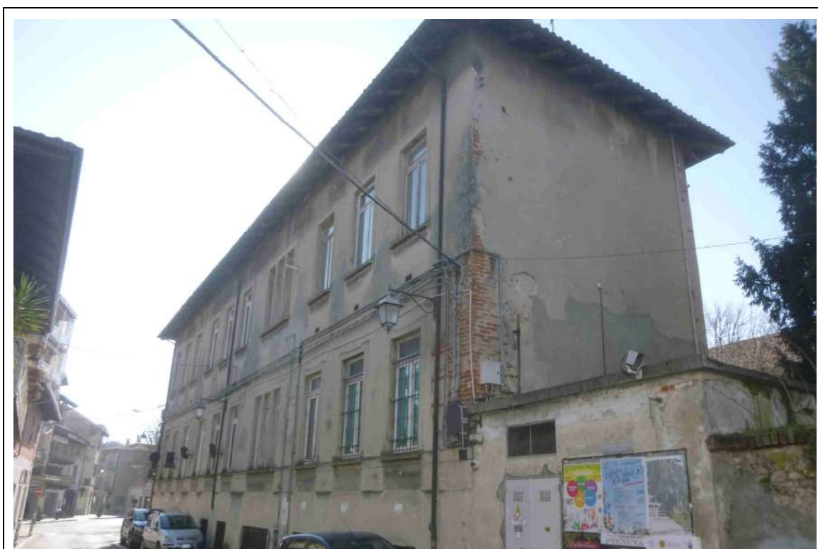
Foto 4 – Stato di fatto – Facciate lato nord e ovest
