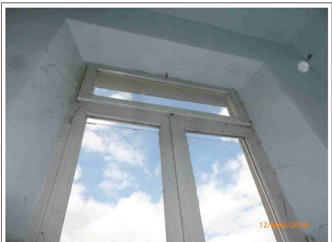
Foto 16 – Stato di fatto – Dettaglio serramenti
