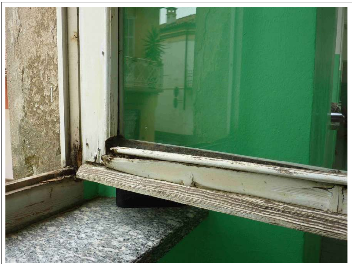
Foto 15 – Stato di fatto – Dettaglio serramenti
