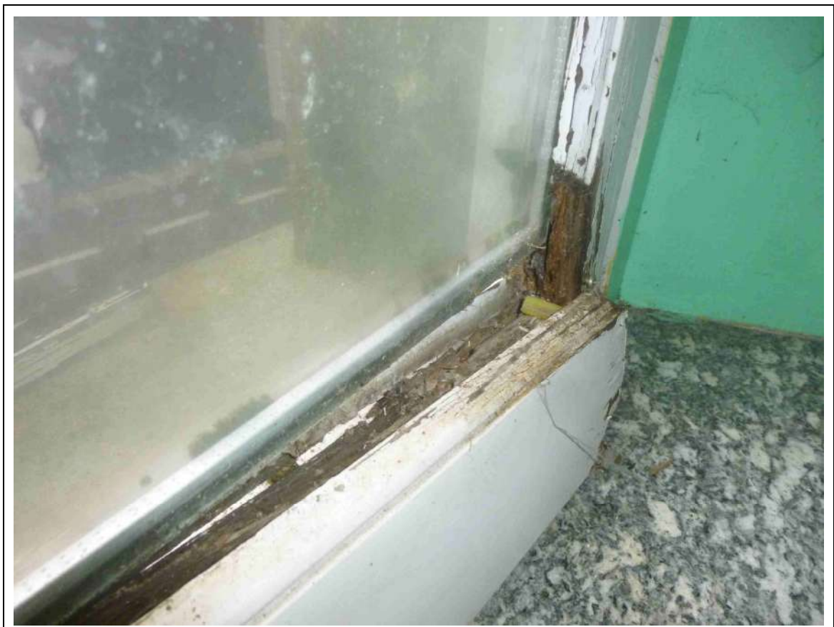
Foto 13 – Stato di fatto – Dettaglio serramenti
