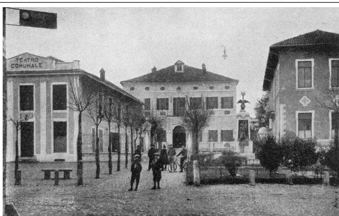
Foto 2 – Epoca, 1930 – Facciata lato sud-ovest.
