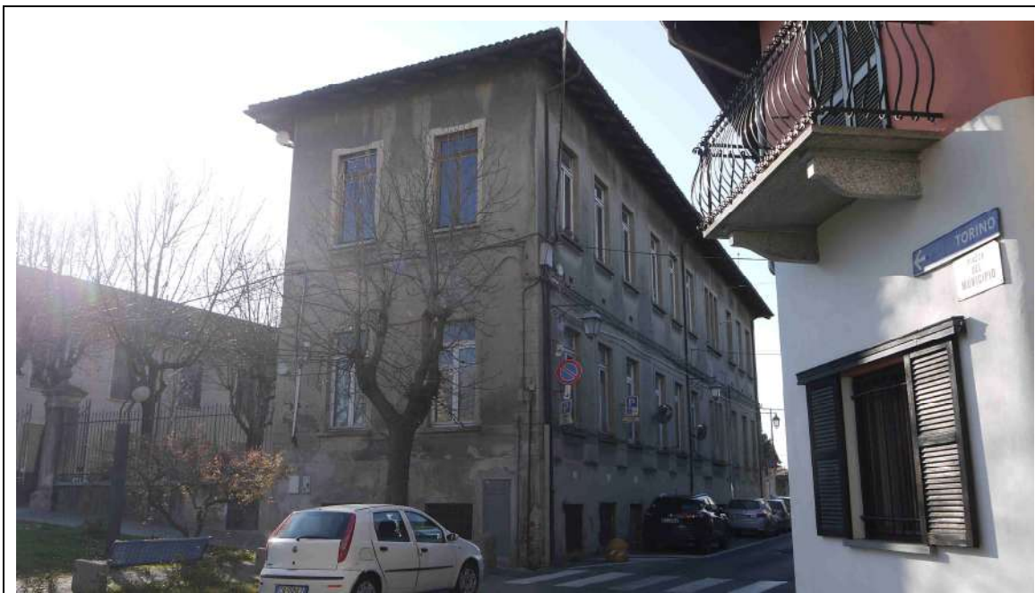
Foto 3 – Stato di fatto – Facciate lato est e nord
