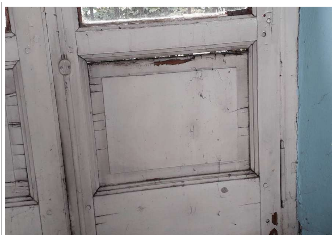
Foto 14 – Stato di fatto – Dettaglio serramenti
