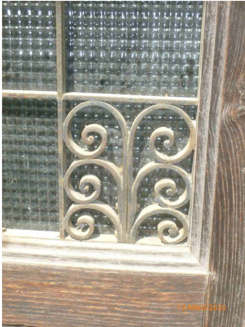
Foto 20 – Stato di fatto – Dettaglio inferriata porta ingresso
