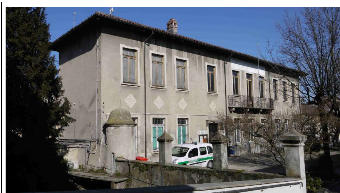
Foto 1 – Stato di fatto – Facciate lato sud e ovest
