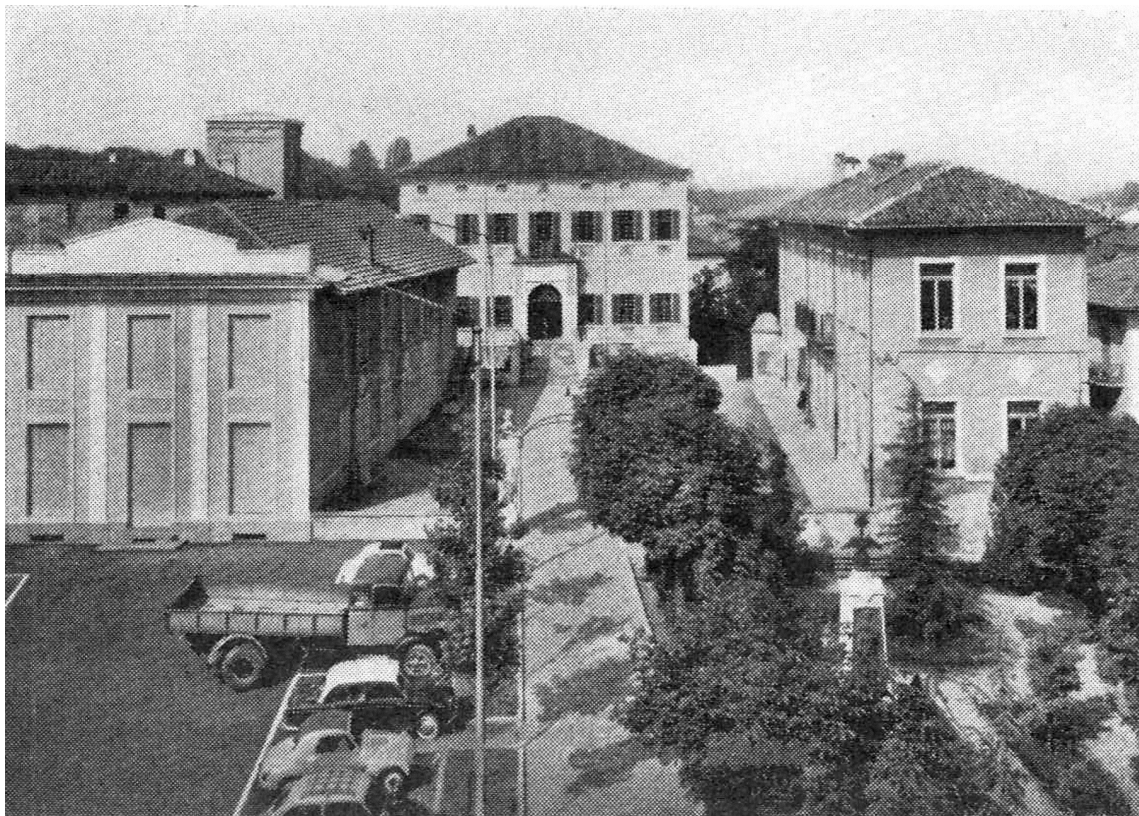
Foto 2 – Epoca, 1962 – Facciata lato sud-ovest.
