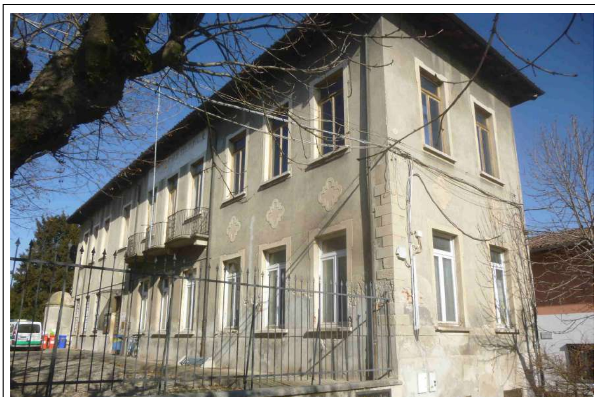
Foto 2 – Stato di fatto – Facciate lato sud e est
