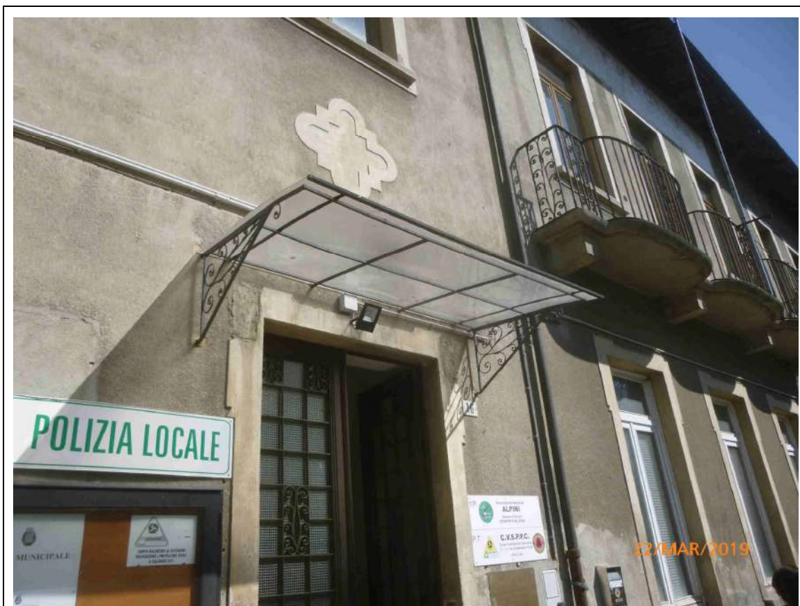
Foto 21 – Stato di fatto – Dettaglio pensilina ingresso
