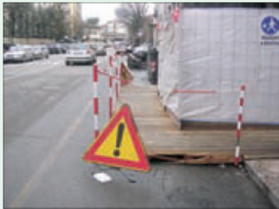
Situazione regolare, il passaggio pedonale è ben protetto
