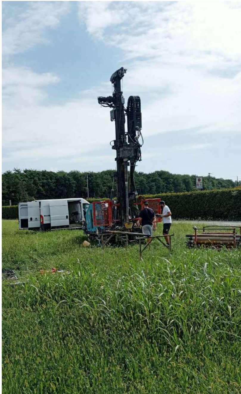
Postazione Sondaggio SA
