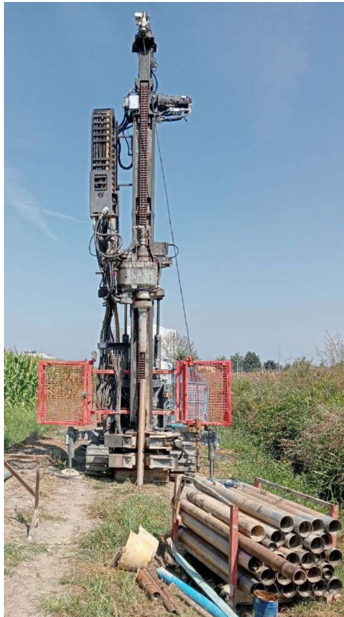
Postazione Sondaggio SB
