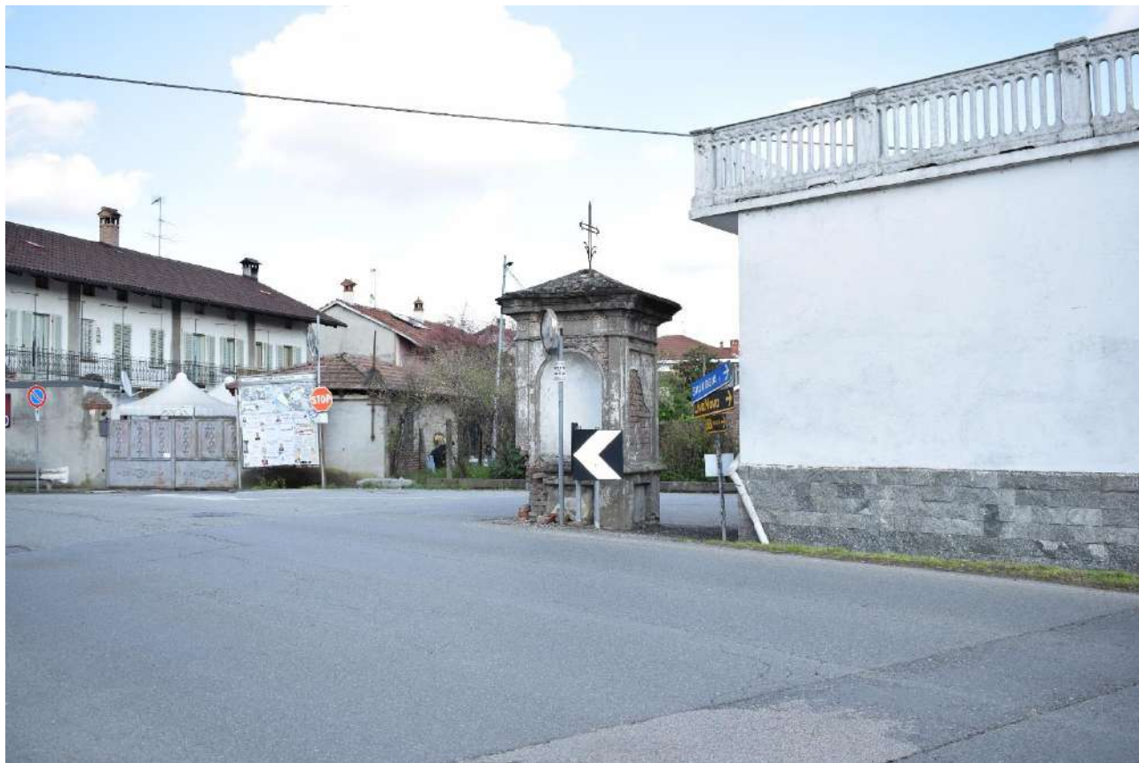
Foto 03 – Vista facciate sud-ovest da via Via XXV Aprile
