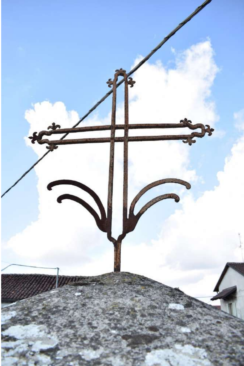
Foto 12 – Dettaglio copertura e croce in ferro battuto
