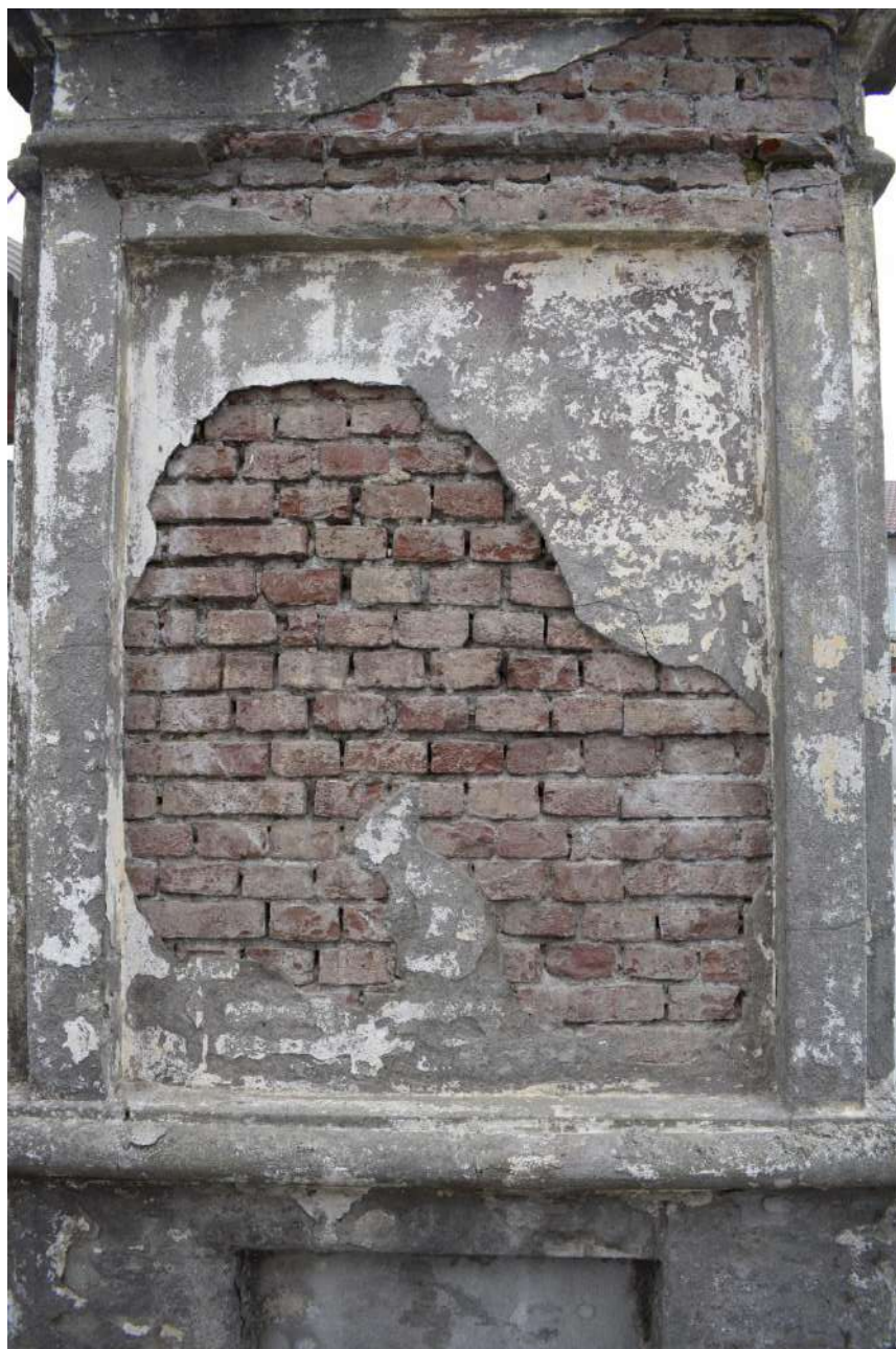
Fronte Sud – Croce
