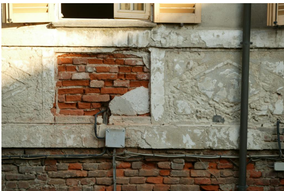
Particolare dell'apparato murario in mattoni
