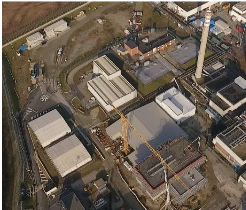
Impianto CEMEX del Sito EUREX di Saluggia in fase di realizzazione – Fonte SOGIN
