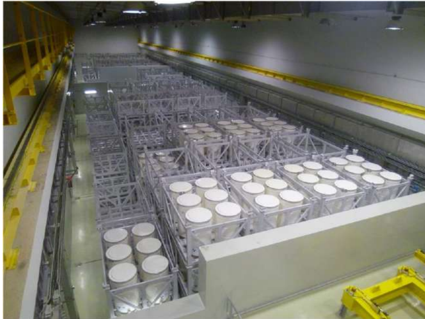
Nuovo Deposito Temporaneo Rifiuti D2 del Sito EUREX di Saluggia – Fonte SOGIN
